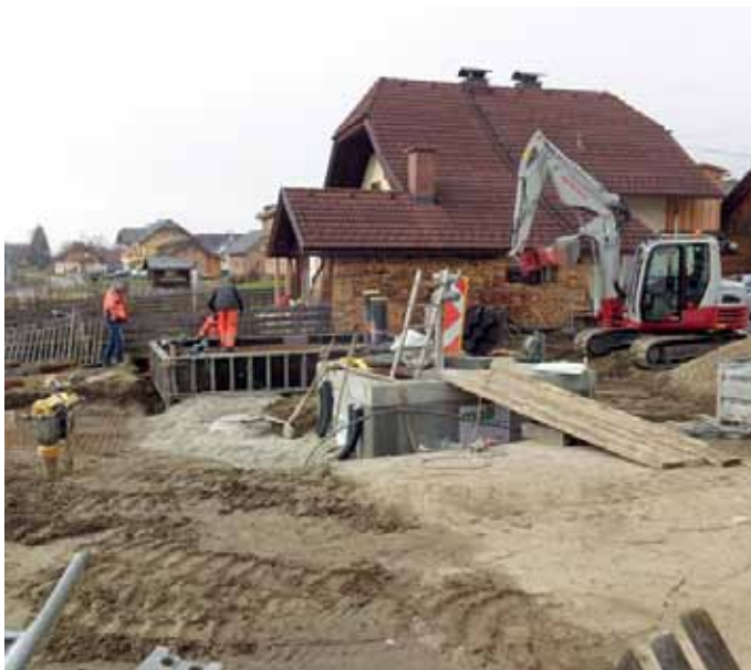
Errichtung des stationären Pumpwerks ....
