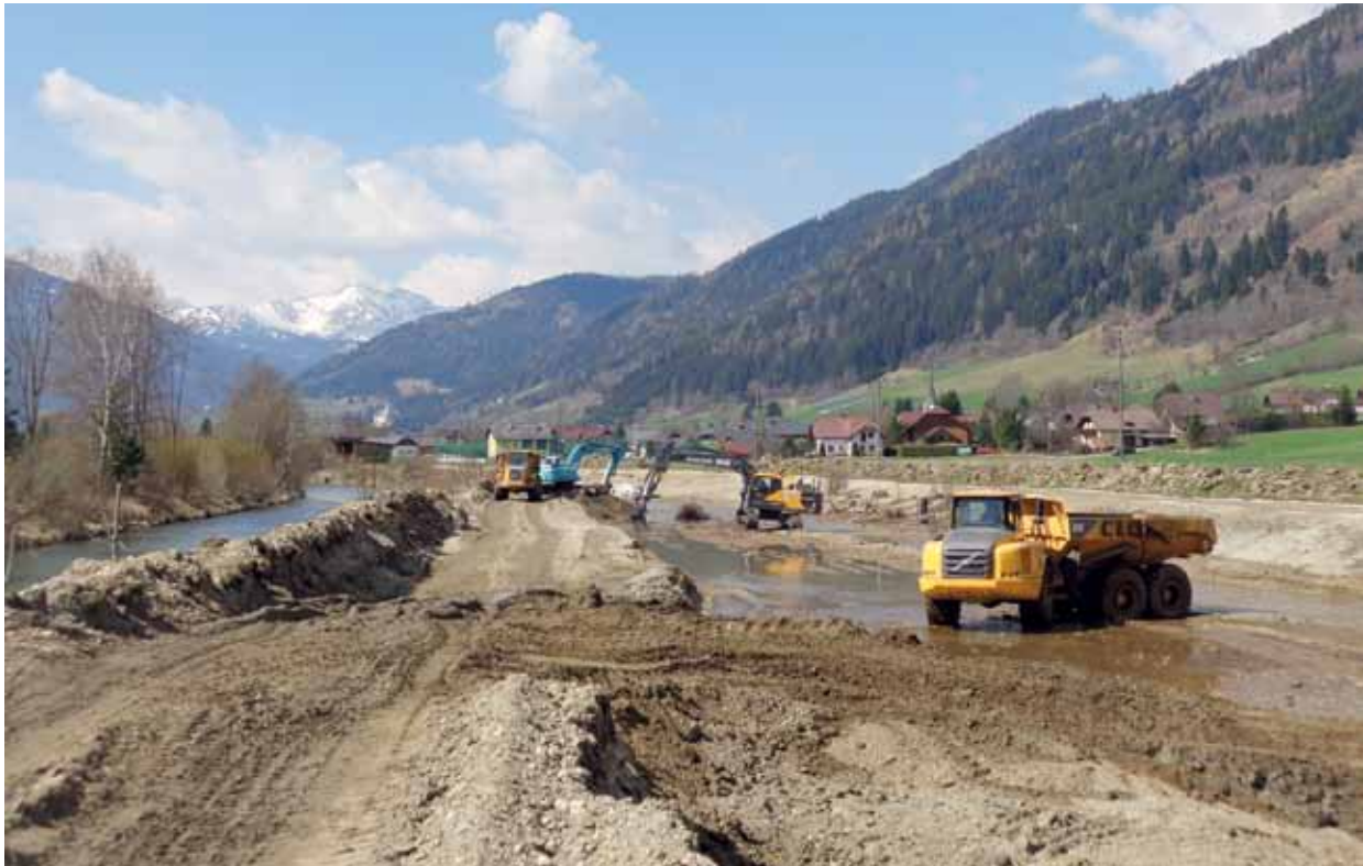
Baugeräteinsatz für Muraufweitung
