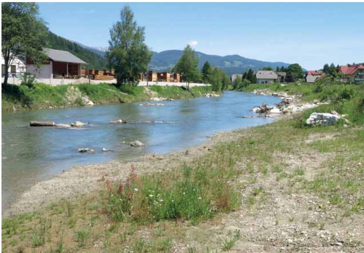
HWS-Mauer und Muraufweitung Sägewerk Graggaber
