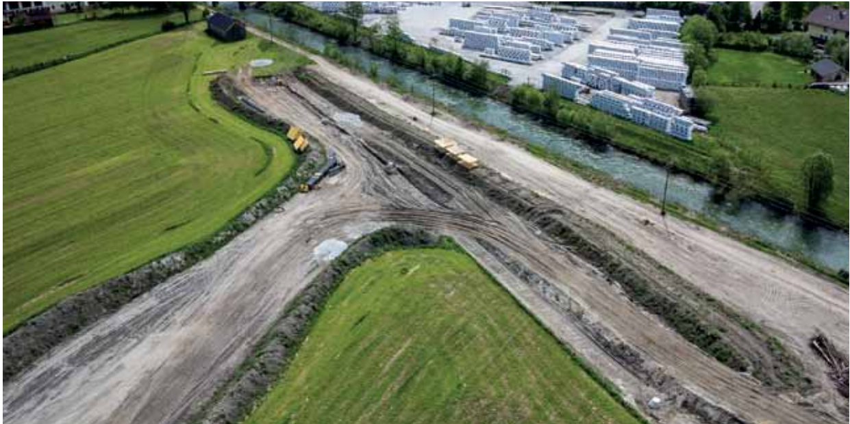
HWS-Damm und Muraufweitung während ....
