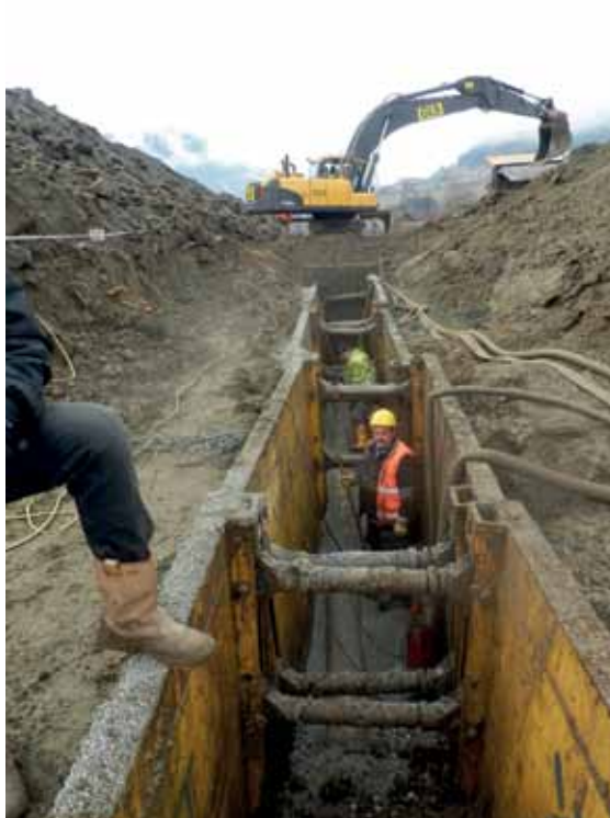
Künnettenverbau Kanalumlegung
