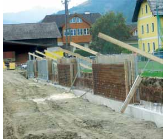
HWS-Mauer bei Sportplatz
