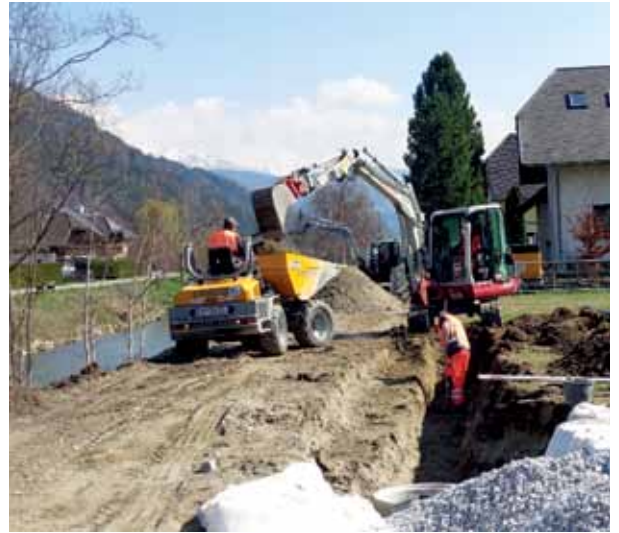
Aushub HWS-Mauer
