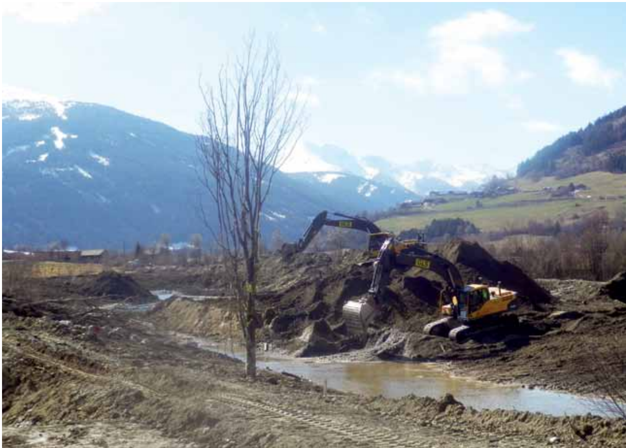
Erdarbeiten für Muraufweitung
