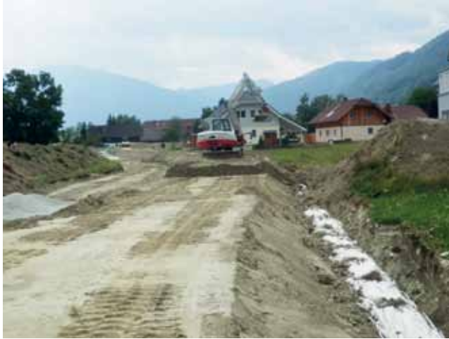
Von Mur abgesetzter HWS-Damm
